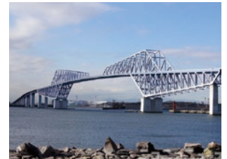
東京ゲートブリッジ
